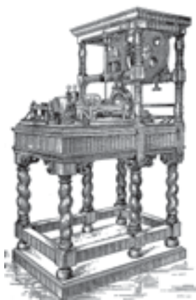
Рис. 4.4. Токарно-копировальный станок А. Нартова (1712)
