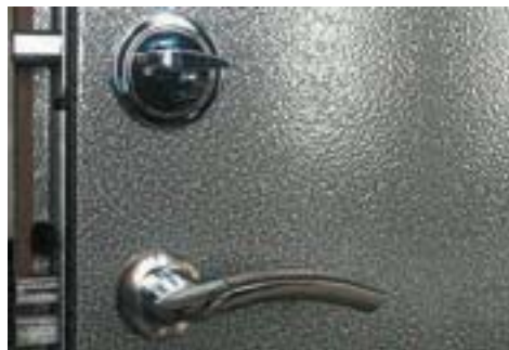
Рис. 2.8. Фрагмент металлической двери с порошковым напылением
